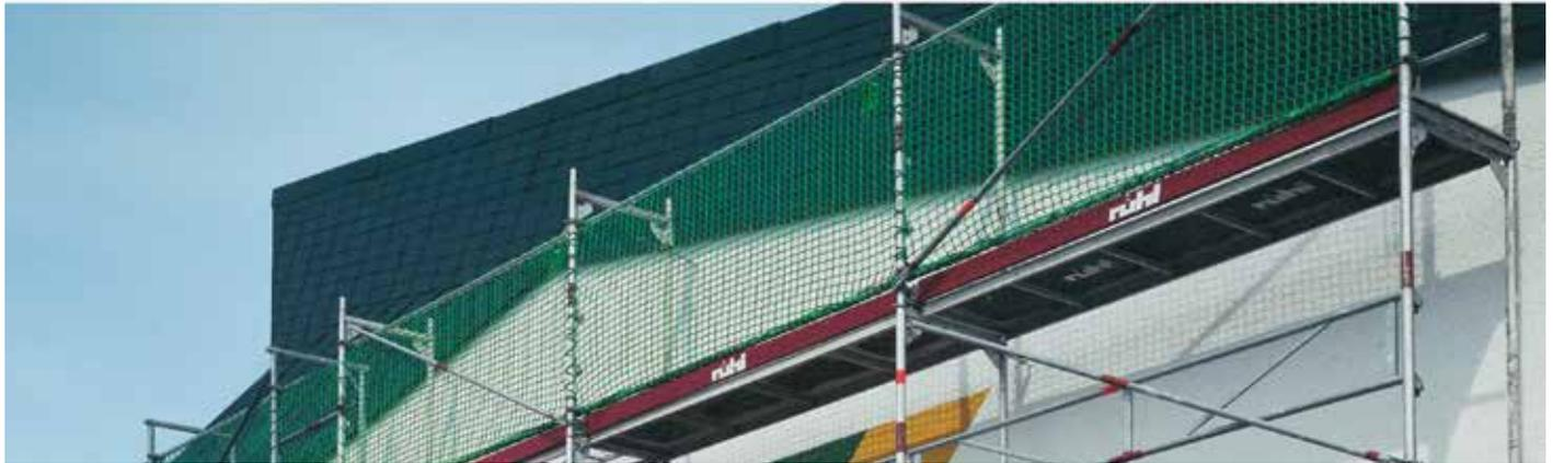
Knotenlose Seitenschutznetze aus Polypropylen hochfest, ca. 5 mm, ringsum mit angekettetem Einfaßseil. Von der Bau-BG zugelassen, mit GS-Prüfbescheinigung 03005.
